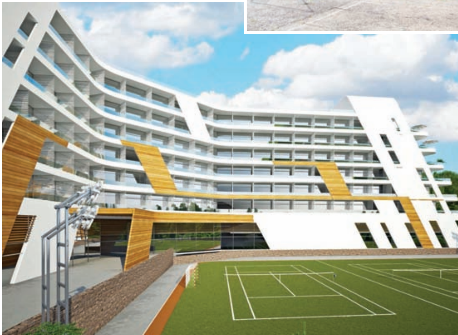
В ялтинском посёлке Гаспра на месте разрушенного стадиона появится современный спортивный комплекс.
