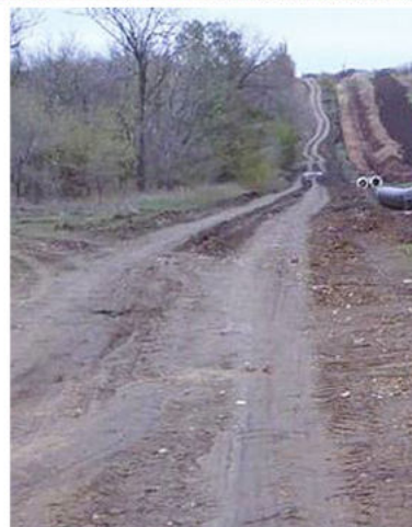
Строительство Бештерек-Зуйского водозабора и водовода на Симферополь идёт в две смены. Фото: Минстрой РК
