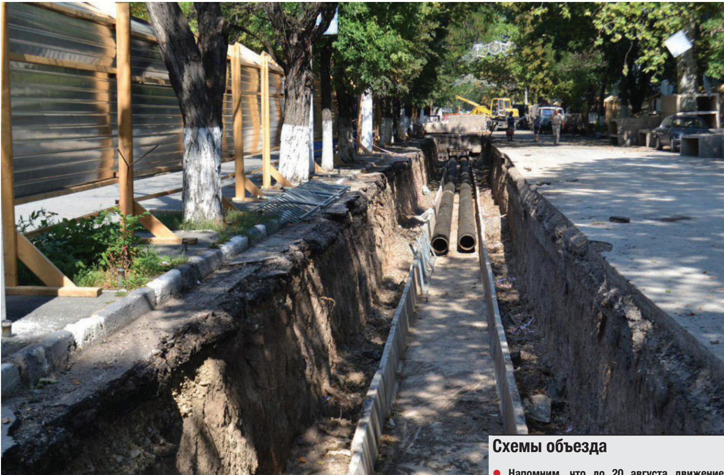
8 августа. Симферополь. На улице К. Маркса идёт ремонт теплотрассы, но дорожное полотно снимать полностью не будут. Фото: Мария УСТИНОВА
