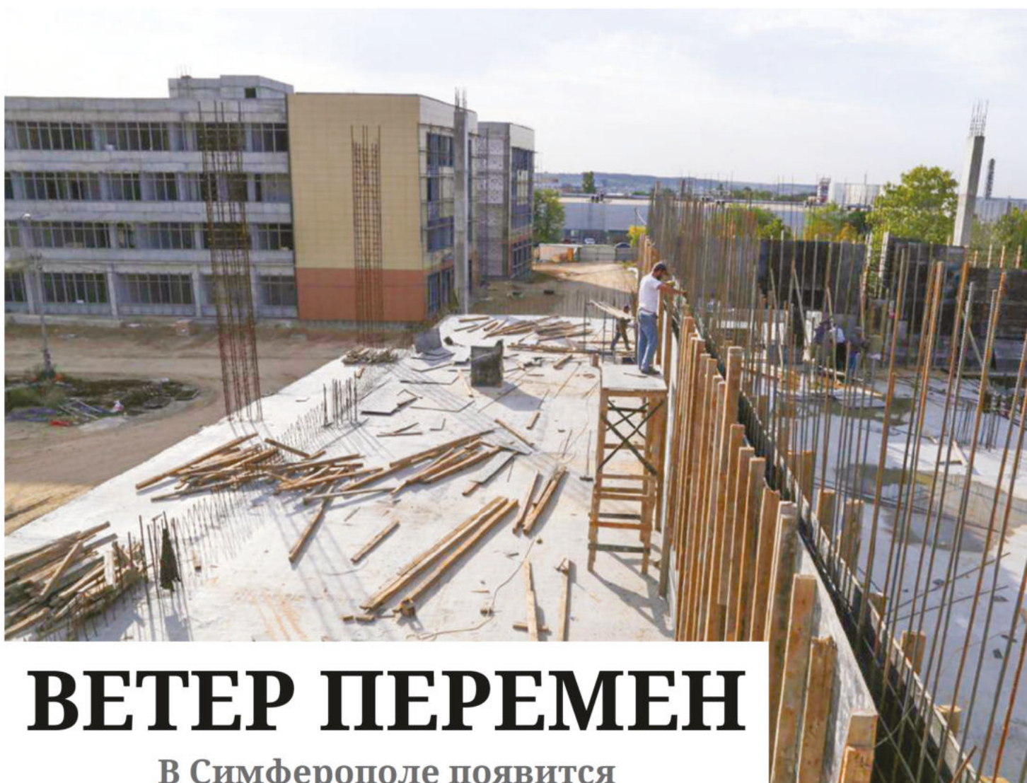
Строительство нового кампуса КФУ. Фото: Наталья СОМОВА
