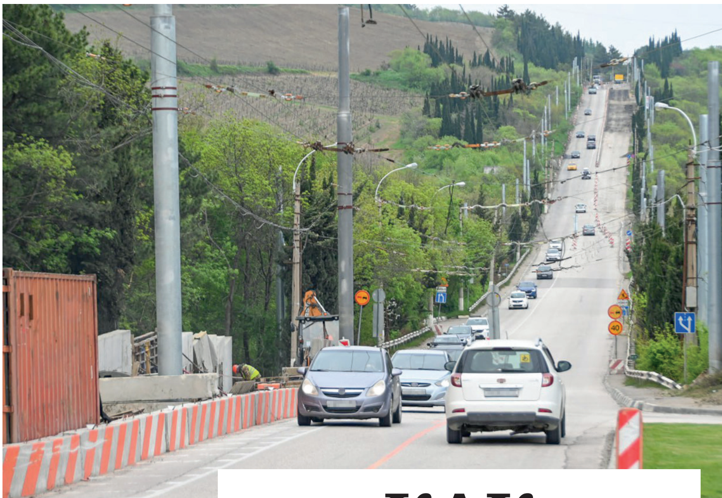
Большие дорожные работы идут сейчас вдоль Южного берега Крыма, по дороге на Ялту. Фото: Гала АМАРАНДО
