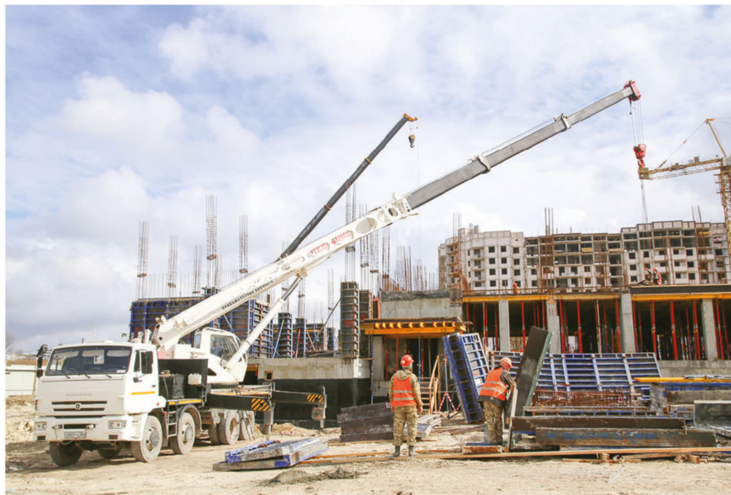
Строительство детского сада на 260 мест в районе улиц Ангарской и Батурина г. Симферополя. Фото: Лидия ВЕТХОВА
